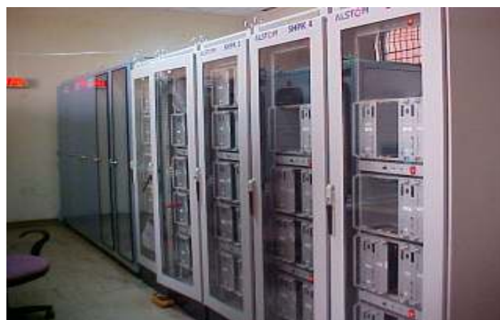
Interlocking cubicles
